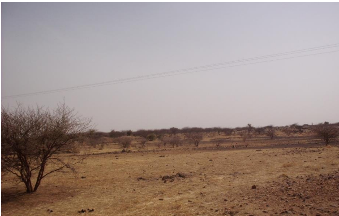
Paysage arboré à l'entrée d'Aioun en parcours du tracé des pylônes
