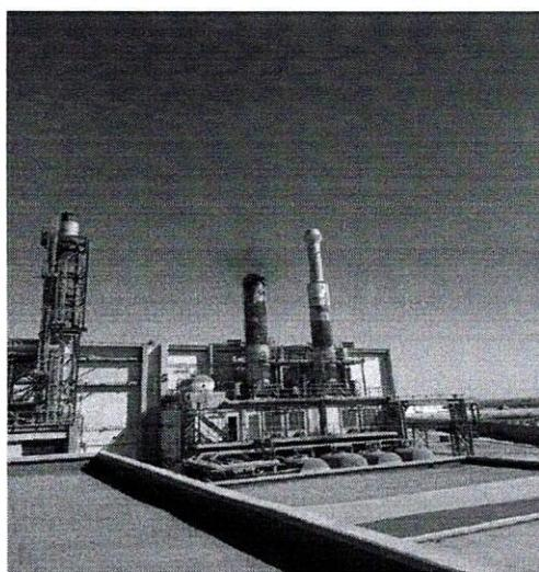
Photos. Cheminée du DG08 à Gauche de la photo avec un nouveau design et celle anciennes des DG05 et DG06 sur la droite de la photo.
