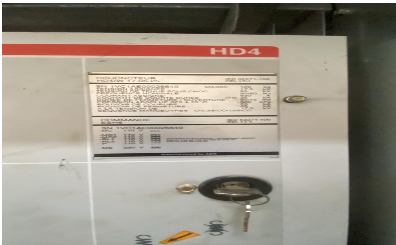
Img4 : Plaque de signalétique disjoncteur départ transfo 15kV
