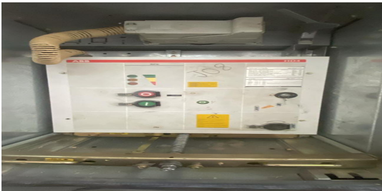
Img4 : Disjoncteur 15kV
