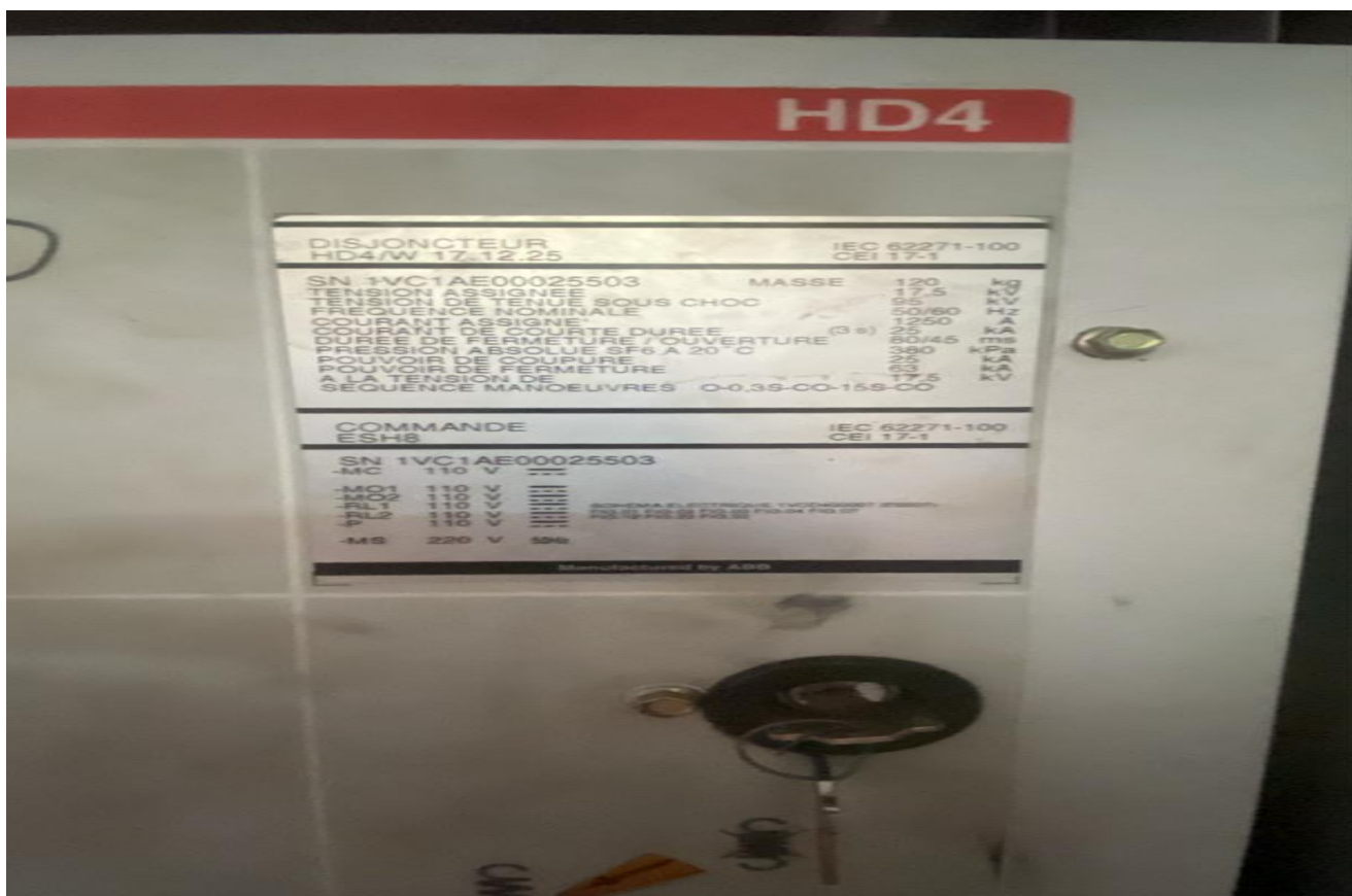
Img 3 : Plaque signalétique du disjoncteur couplage 15kV
