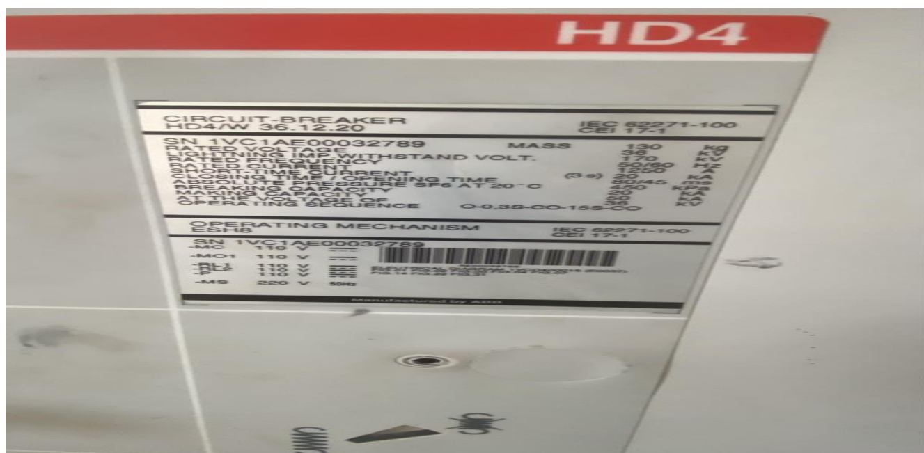
Img 2 : Plaque signalétique du disjoncteur 33kV
