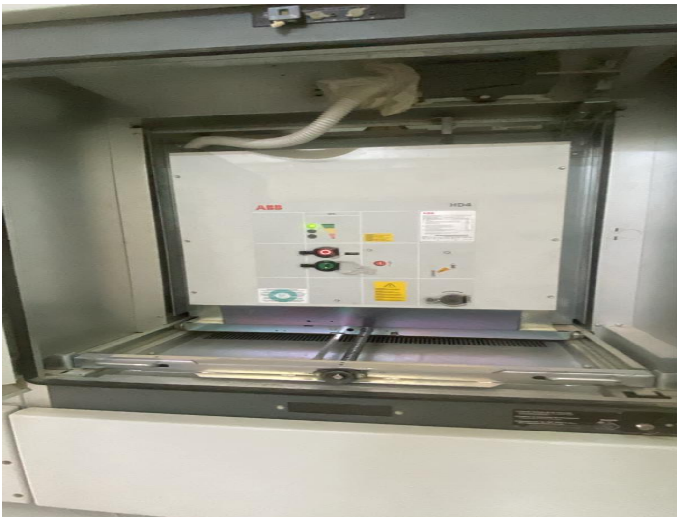
Img1 : Disjoncteur 33kV
