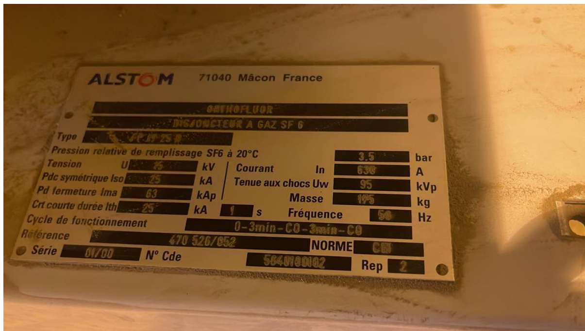
Spécifications techniques du disjoncteurs 15kV
